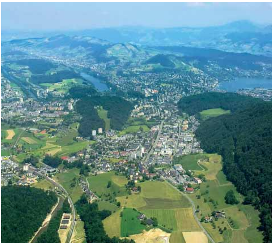
Wenn sich die Stadt Luzern und die Agglomerationsgemeinde Littau (im Vordergrund) zusammenschliessen, entsteht eine Stadt mit mehr als 73 000 Einwohnern.
