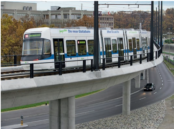
Glattalbah auf Viadukt.
