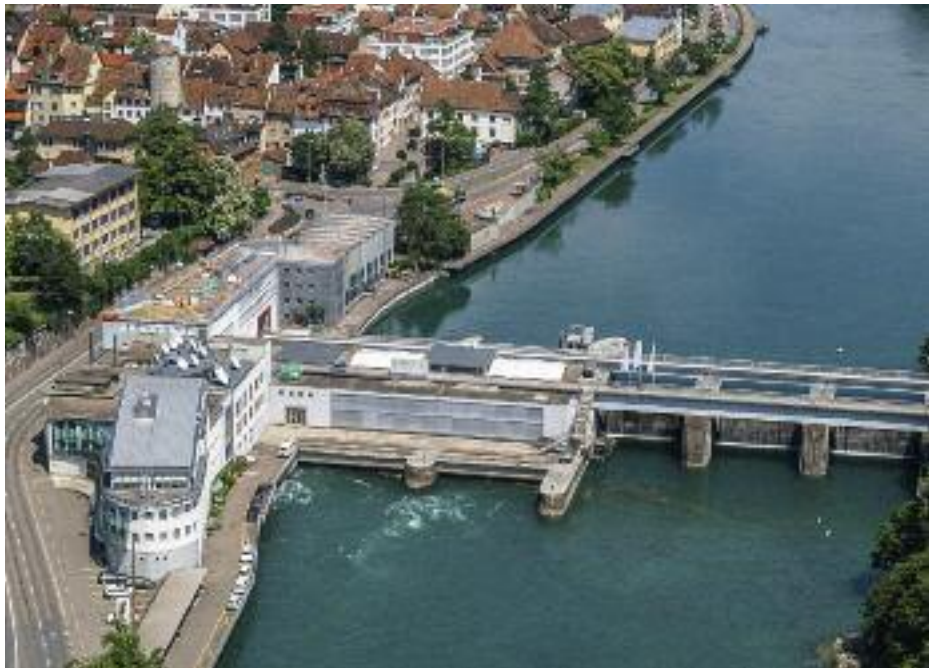
Das Rheinkraftwerk in Schaffhausen. Ein Baustein der 2000-Watt-Gesellschaft.
